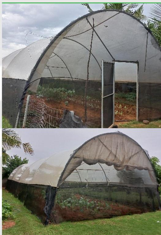
A ESTUFA MODELO TÚNEL ALTO APRESENTA UMA GEOMETRIA DE ARCOS A BASE DE ESTRUTURAS GALVANIZADAS PERMITINDO BOM APROVEITAMENTO DE LUZ. NO CASO DE MOÇAMBIQUE, RECOMENDAMOS SUA INSTALAÇÃO PARTICULARMENTE EM REGIÕES DE ALTITUDE, E FRIAS.
